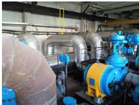
Рисунок 5 – Внедрение узла рециркуляции в схеме насоса №3 на насосной станции №2 Северного сетевого района
