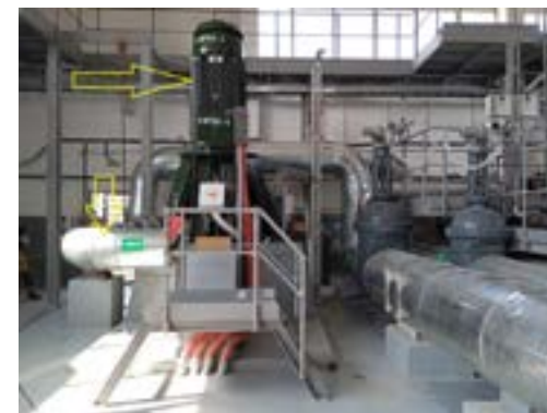
Рисунок 6 – Внедрение узла рециркуляции с применением вертикального насоса ЦТП-73
