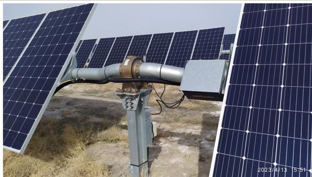
Рисунок 10 – Общий вид СЭС и поворотного механизма панели
