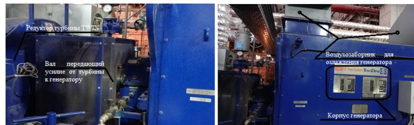
Рисунок 5 – Генератор вид генератора и турбины на воздухозаборник
