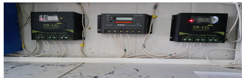
Рисунок 5 – Контроллеры серии SR-LG60A Series и PWM solar charge controller VS4548BN
