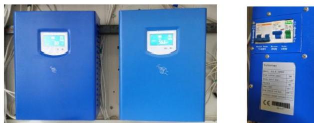
Рисунок 6 – Контроллеры для ветрогенератора серии Exmork ZKJ-B 3KW-48Vdc
