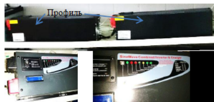
Рисунок 4 – Два однофазных инвертора напряжения Power Star W7 6000W-48V
