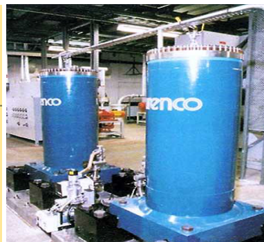
Рисунок 2 – Общий вид роторного электромашинного накопителя
