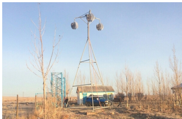
Рисунок 7 – Ветрогенератор ТОО «I.Zhel» установленный в Аральском лесопитомнике
