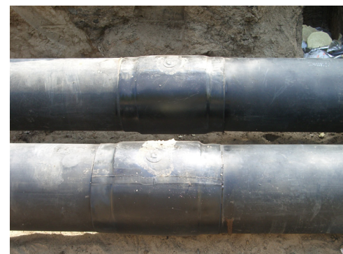
Рисунок 3 – Вид муфт после установки
