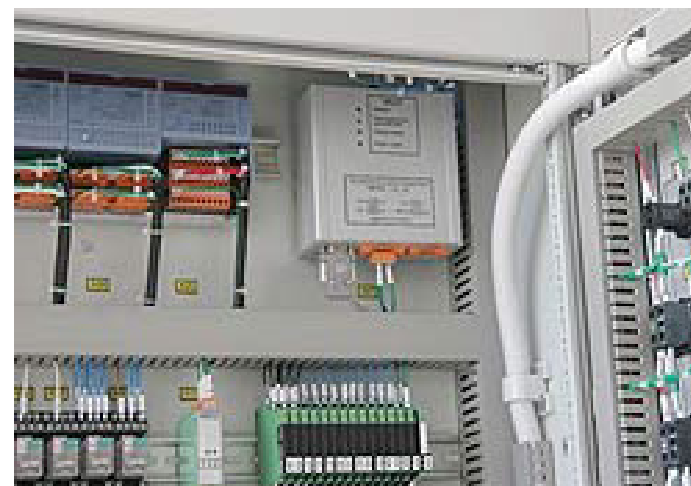
Рисунок 6 – Преобразовательный модуль в отсеке управления
