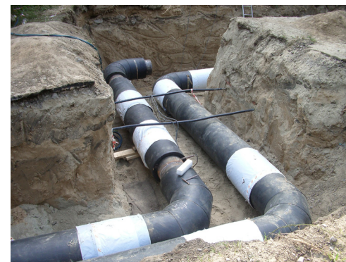
Рисунок 2 – Участок тепловой сети до установки муфт на стыковых соединениях
