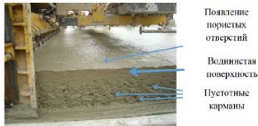
Рисунок 5 – Проблемы при укладке бетонной смеси [4].
