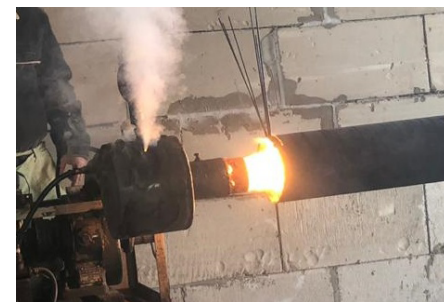
Рисунок 2 – Горелка в работе
