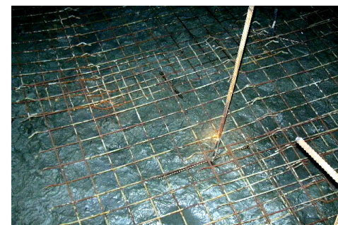
а) вид армировки на почве слоя перед закладкой
