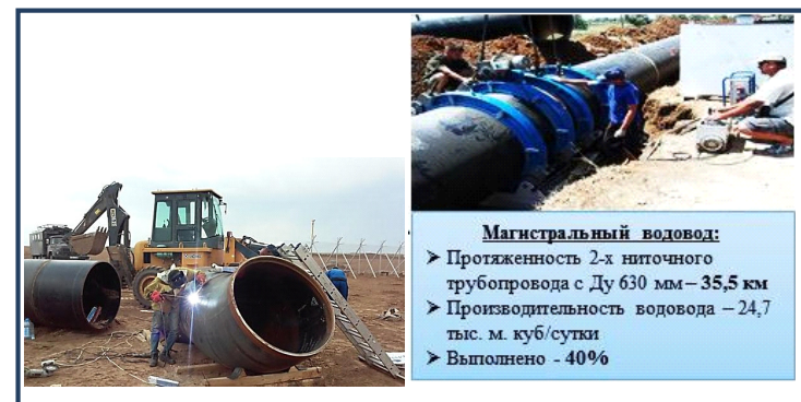
Рисунок 1 – Строительство водовода [1]
