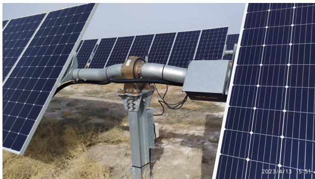
Рисунок 10 – Общий вид СЭС и поворотного механизма панели
