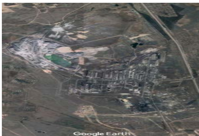
Рисунок 3 – Хранилище техногенных отходов Аксуйский завод Ферросплавов
