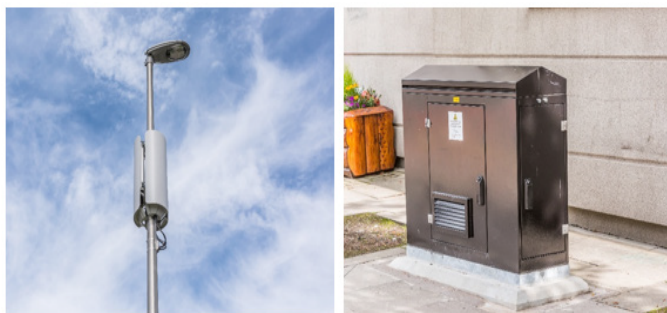
Сурет 2 – Шағын ұяшықтарды және сыртқы шкафты қолдайтын антенна жүйесі
