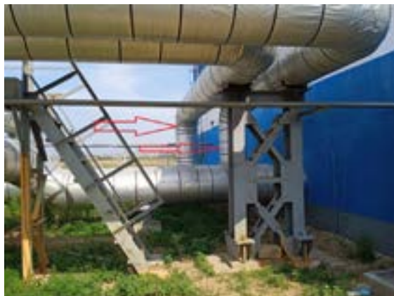
Рисунок 7 – Внедрение узла рециркуляции на ЦТП-73. Дополнительные связи и врезки
