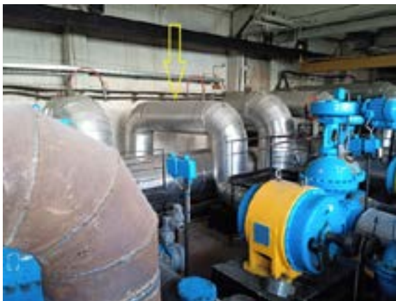
Рисунок 5 – Внедрение узла рециркуляции в схеме насоса №3 на насосной станции №2 Северного сетевого района
