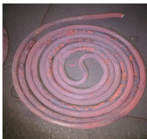
Рисунок 2 – Наружная поверхность труб змеевиков
