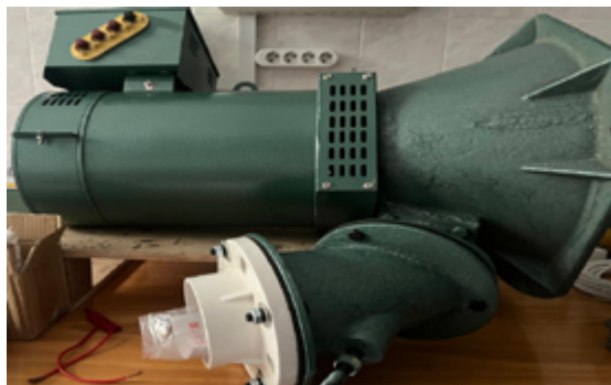
1–сурет Шағын су электр станциядағы синхронды генератор
