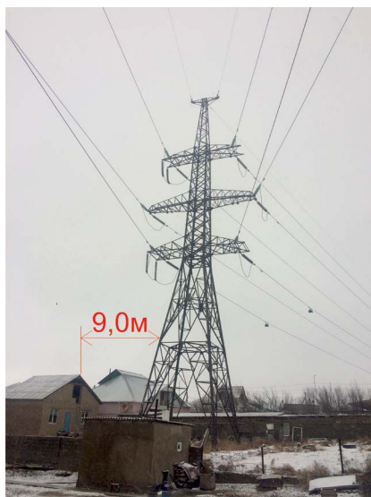
Рисунок 1 – Общий вид опоры и ВЛ-220 кВ и место расположения жилых домов микрорайона Казыгурт
