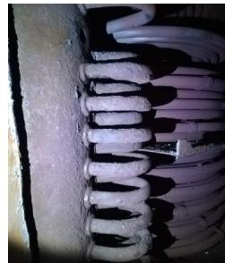
Рисунок 1 – Общий вид системы змеевиков ПВД после вскрытия
